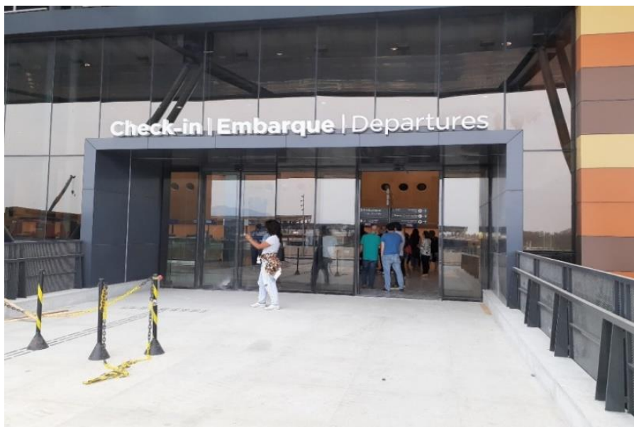
Figura 28 – Visita Técnica ao Floripa Airport – Acesso Check-in
