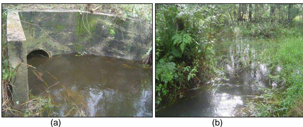
Figura 13 - (a) Local de saída da água de drenagem da Fazenda após evento chuva intensa. (b) Canal da Tapera, após saída da drenagem da Fazenda (Foto de Fev. 2010).
