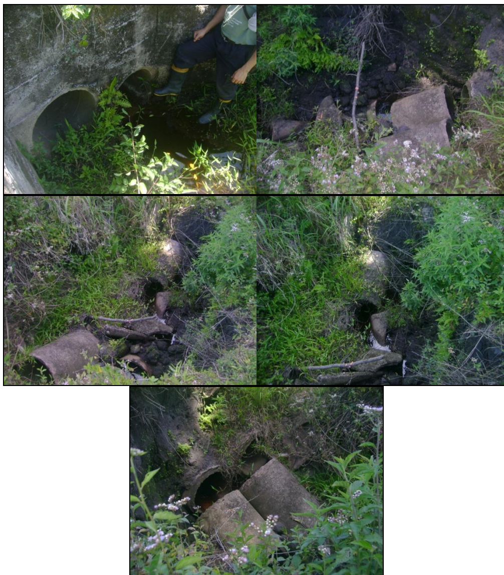
Figura 11 – Canalizações da saída da drenagem da Fazenda Ressacada. (Fotos: Novembro 2011).
