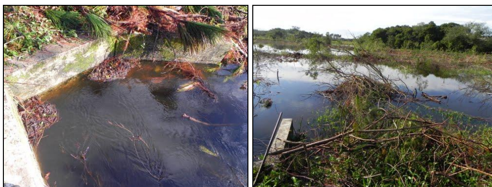
(a) (b) Figura 14 - (a) Local de saída da água de drenagem da Fazenda após evento chuva em abril de 2010, estrutura submersa sob a capacidade limite. (b) Aspecto do local nesta ocasião: região alagada.
